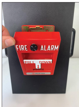
FIGUR 8: NULLSTILLING AV CALL POINT MED TREKKFUNKSJON
